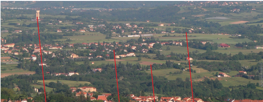
Le plateau entre Chaponost et Brindas, le repère du château d'eau de Chaponost : un mitage important du territoire Le château d'eau Brindas Bocage de plateau Aérodrome
