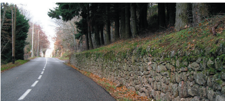
Les magnifiques murets qui bordent la route en entrée d'Yzeron
