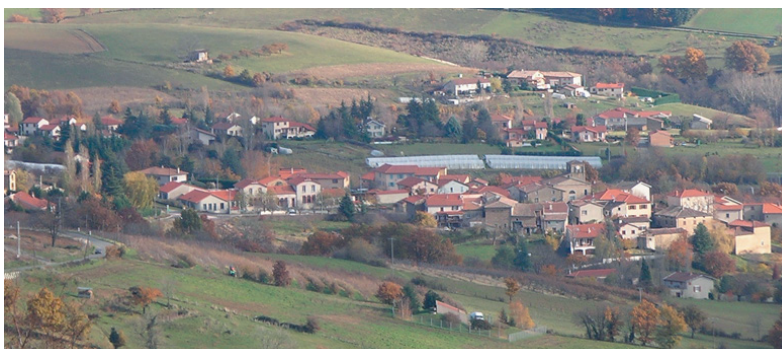
Chaussan, implanté en partie haute du plateau Mornantais
