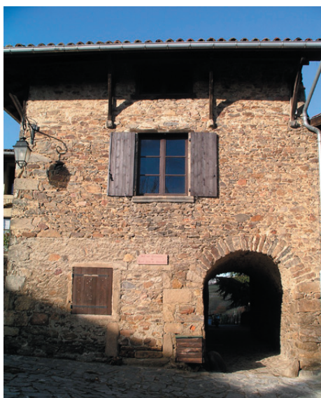
Maison du village de Riverie
