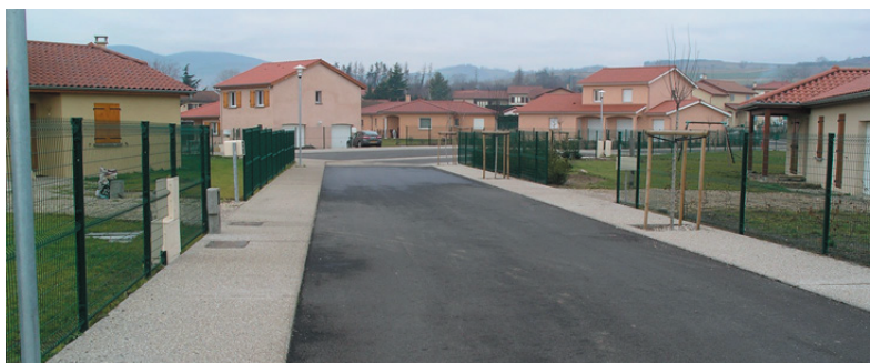
Une voirie de lotissement récent à St Laurent d'Agny
