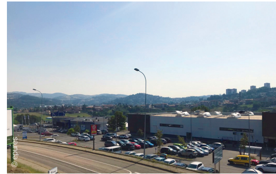
Zone commerciale de Villars Montravel (42), accès privilégié par la voiture
